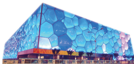
水立方外立面膜结构材料
