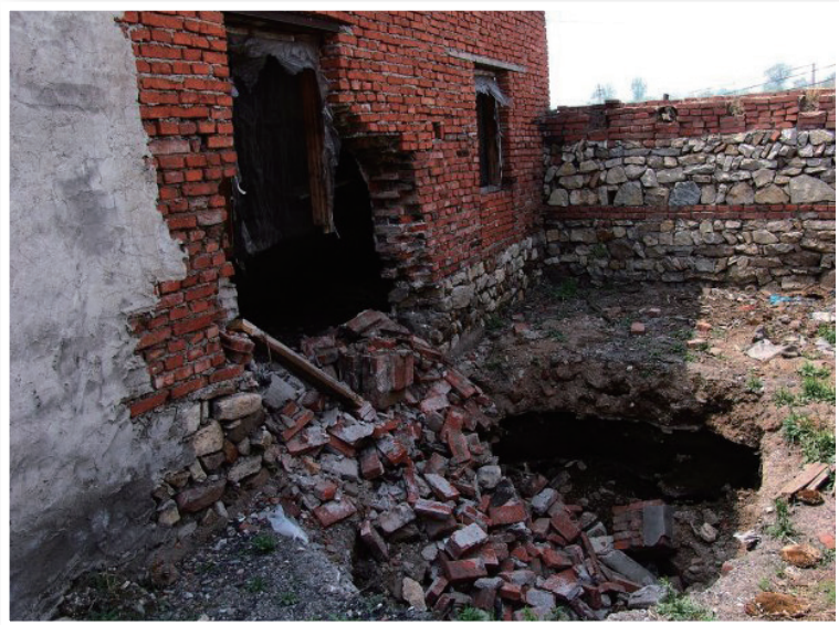
图 2-40 采煤沉陷区塌陷的房屋
